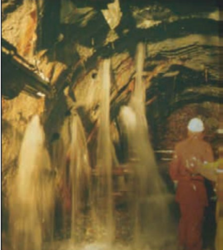
Şekil 2. Kaponig Tüneli' ndeki Su Baskını (Riedmueller ve Schubert, 2002)
